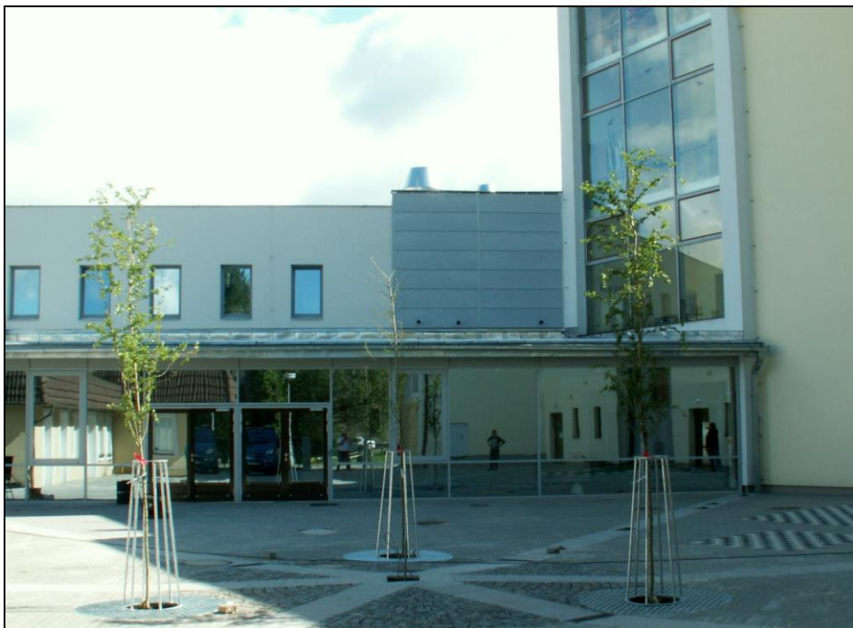
Dostavba budovy základní školy pokračuje
