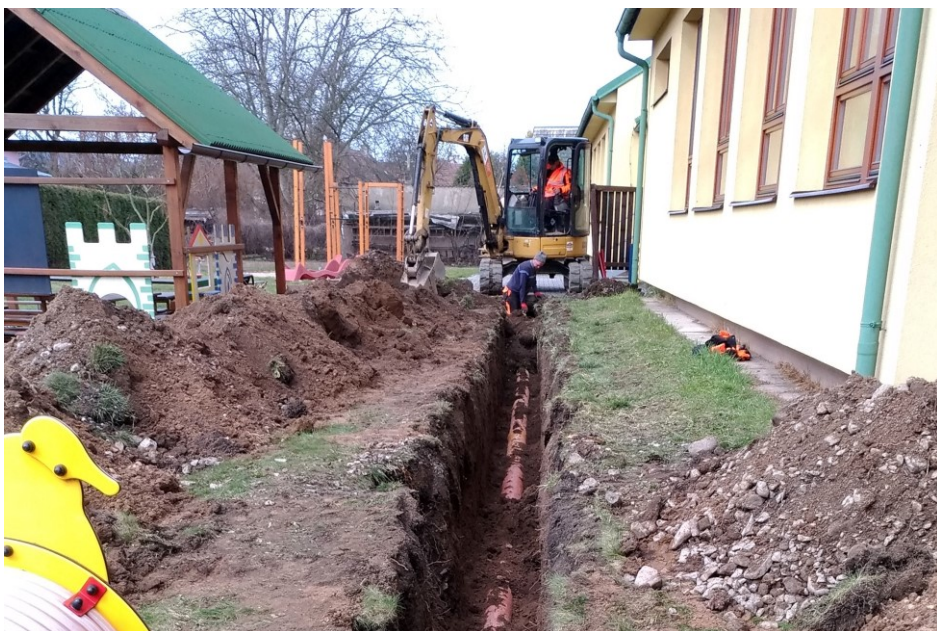
Na zahradě mateřské školy si místo dětí „hráli s bagrem“ při výkopu pro budoucí kanalizaci pracovníci dodavatele.
